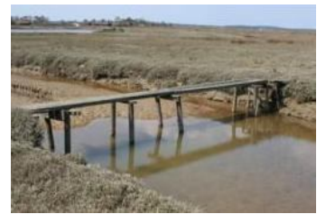
Franchissement sous forme d'une passerelle
