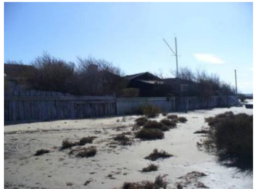
Perrés de protection au quartier de l'Illet
