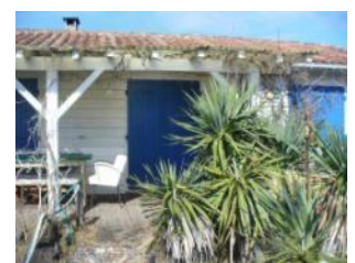
Cabane régulièrement inondée (SOGREAH)
