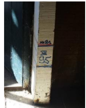
Marquage des inondations (SOGREAH)
