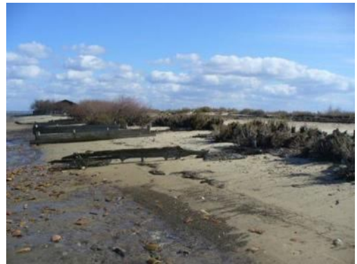
Epis abîmés à l'Ouest du Port de l'île. Zone de sable nu en arrière
